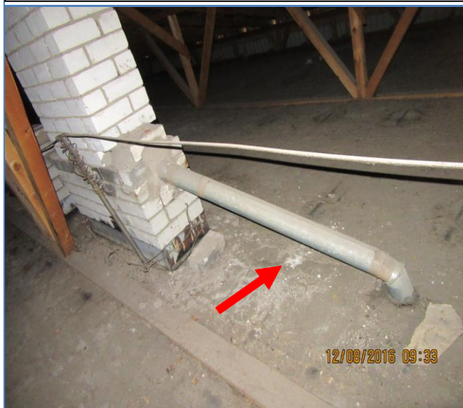
88. att. Nenositināts gaisa vads aukstajos bēniņos.
