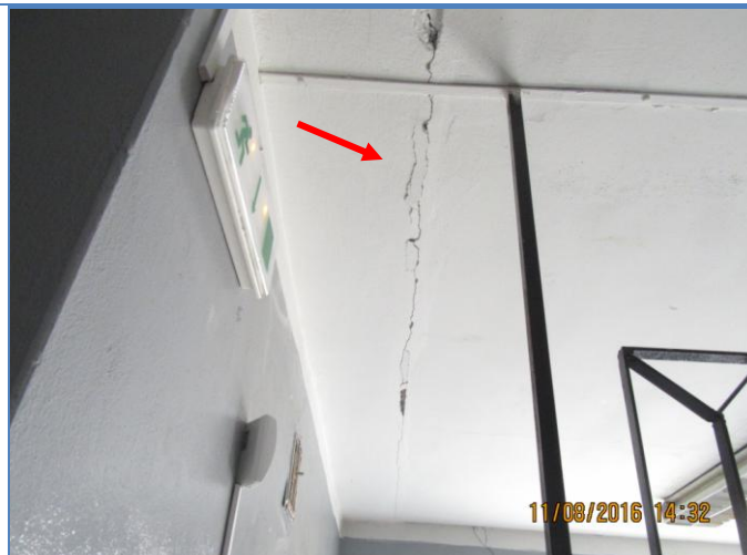
79. att. Plaisājums paneļu sadurvietā autokompleksa kāpņu telpā.
