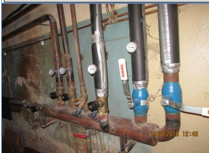
177. att. Morāli nolietots siltuma kolektors .
