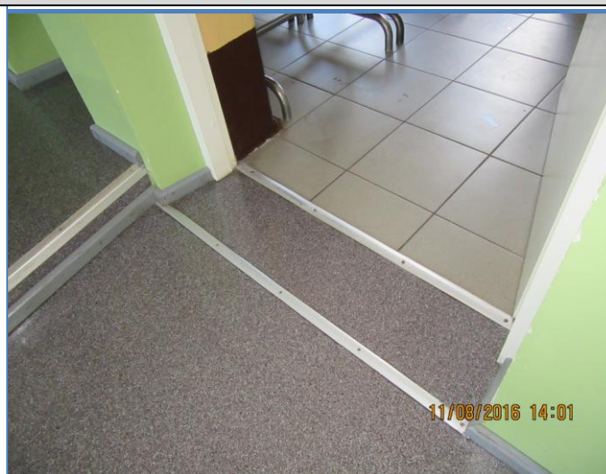
129. att. Pareizi izbūvēts sliekšnis.
