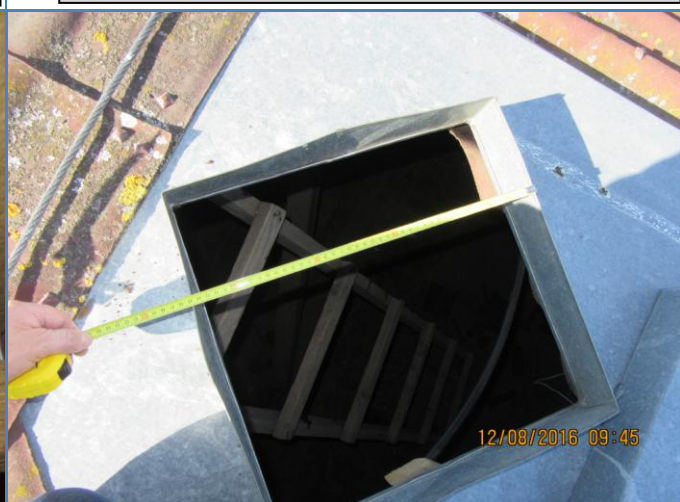
102. att. Neatbilstoša LBN prasību izmēra jumta lūka.
