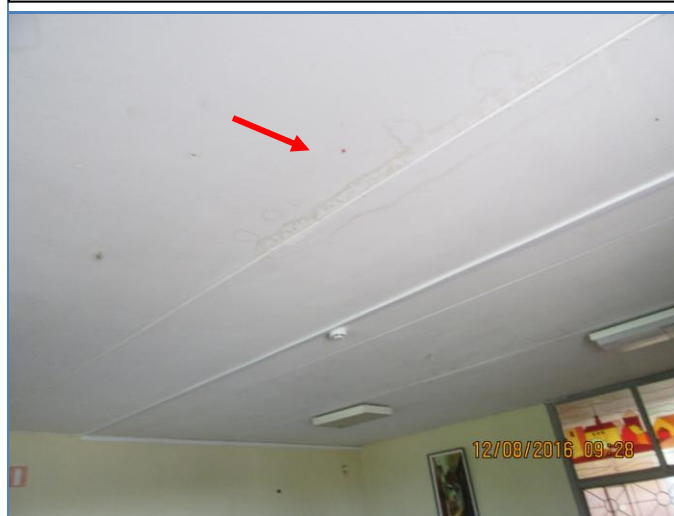
80. att. Griestu notecējumi 3.stāva pārseguma vestibulā.
