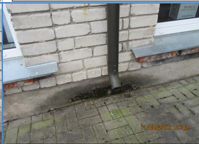
11. att. Nav izbūvēta lietus notekūdeņu novadīšanas sistēma.
