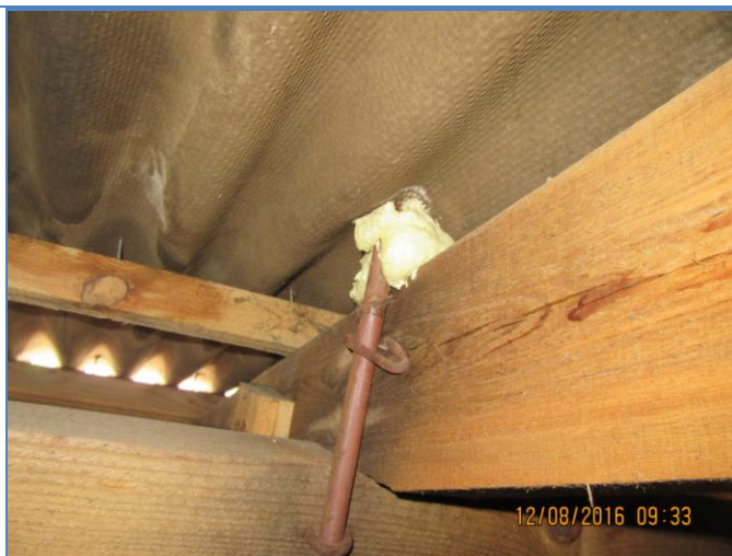
84. att. Jumta drošības barjeras stiprinājums pie jumta konstrukcijas.
