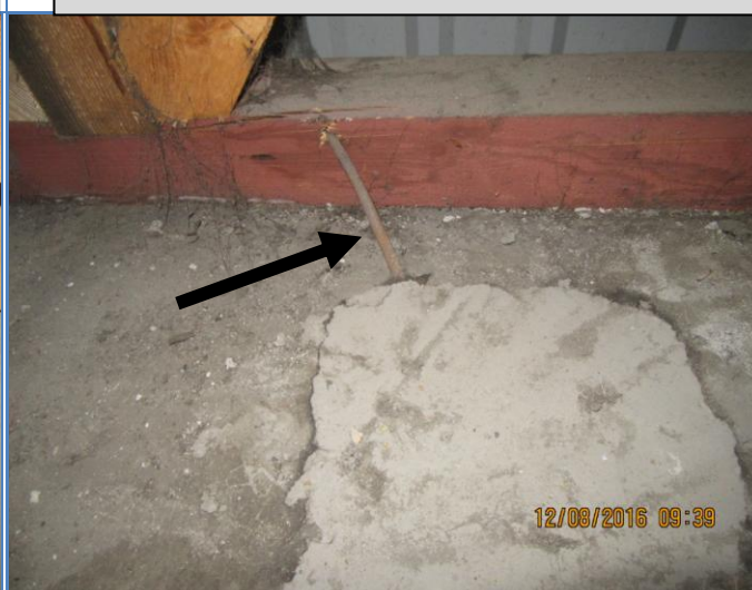
87. att. Jumta ārējās sienas koptura mūrļatās enkurojums pārsegumā.
