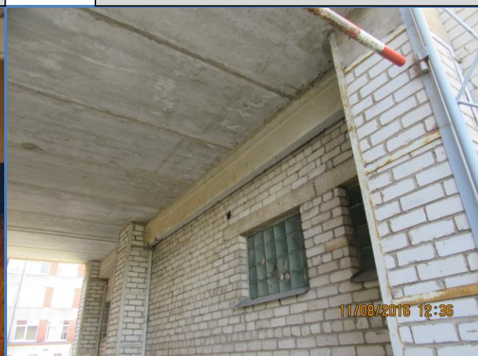
66. att. Caurbrauktuves nesošās sijas un mūra kolonnas.
