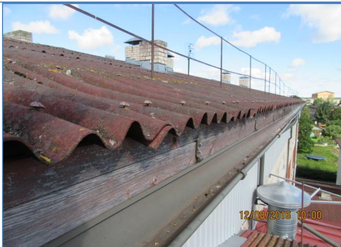
97. att. Skolas ēkas jumta viļņotās bitumena loksnes.
