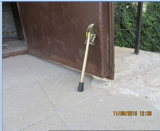
141. att. Korodējušas tērauda ārdurvis.
