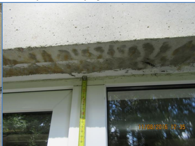
136. att. Apgrūtināta esošo logu ailu siltināšanas iespēja.
