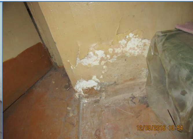
47. att. Sienas kapilārā mitruma bojājumi noliktavas telpā Nr.4.
