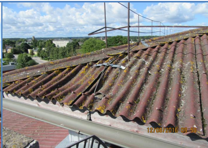
98. att. Skolas ēkas jumta viļņotās bitumena loksnes.
