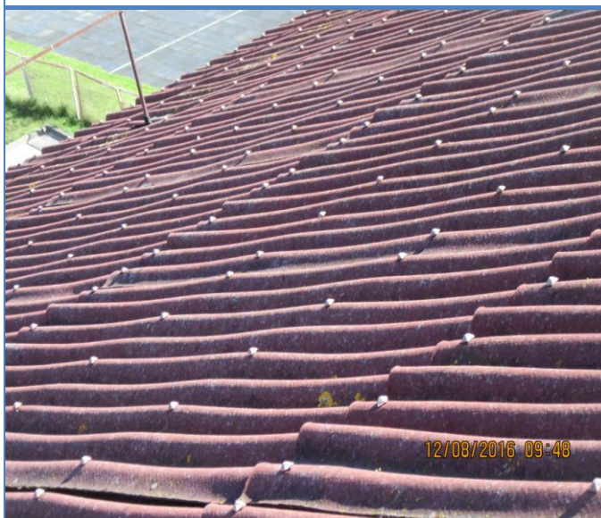
92. att. Skolas ēkas jumta viļņotās bitumena loksnes.
