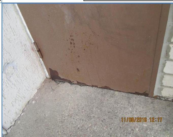
140. att. Korodējušas tērauda ārdurvis.
