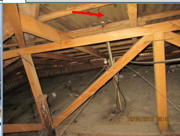
81. att. Nesiltināts bēniņu pārsegums.
