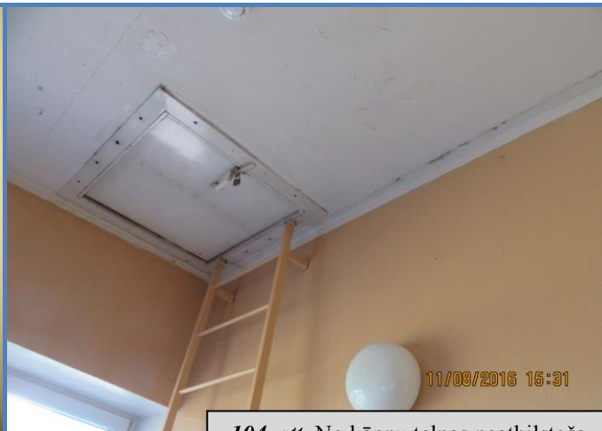
104. att. No kāpņu telpas neatbilstoša LBN prasībām bēniņu lūka.
