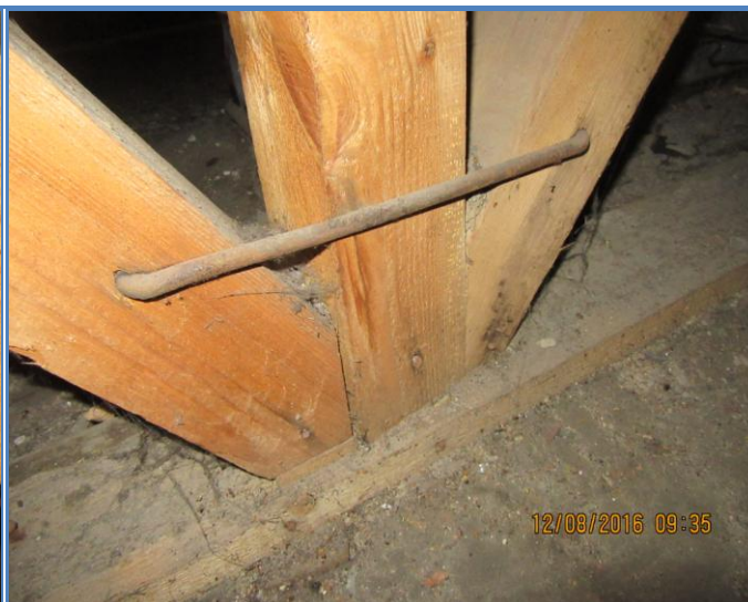
85. att. Jumta koptura apakšējā vaiņaga stiprinājums.
