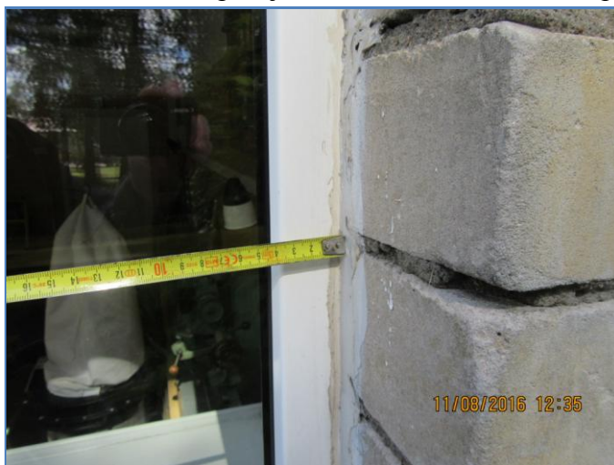
135. att. Apgrūtināta esošo logu ailu siltināšanas iespēja.
