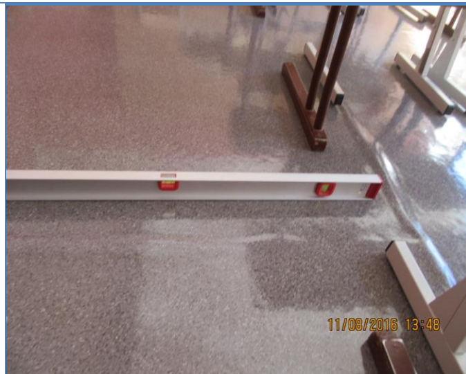
127. att. Linoleja segums ieklāts uz neatbilstošas pamatnes.
