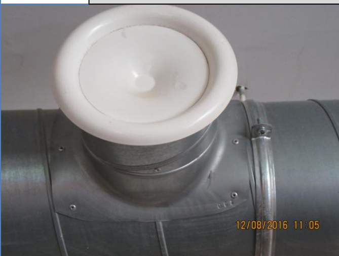
157. att. Zēnu darbmācības aizvērtie gaisa nosūces vārsti.
