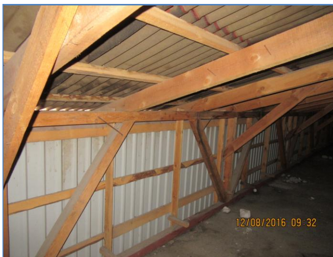
82. att. Jumta krēsla konstrukcija pie ēkas ārsienas.
