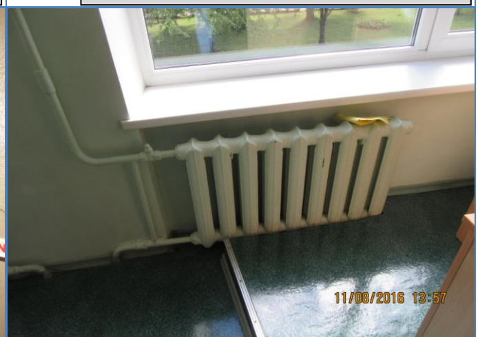
178. att. Grīdā iebūvēts sildķermenis
