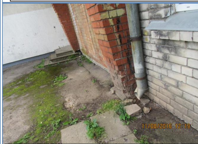
10. att. Nav izbūvēta lietus notekūdeņu novadīšanas sistēma.
