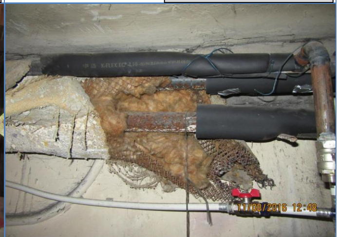
176. att. Nenosiltināti un korodējuši cauruļvadi .
