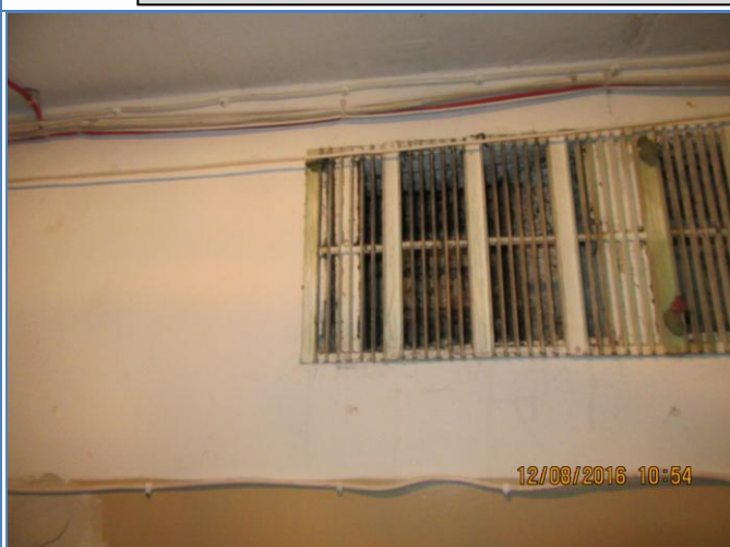
155. att. Pagraba telpu dabīgā ventilācija.
