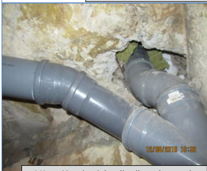
161. att. Nomainītais kanalizācijas vada posms bez ugunsdrošības manžetes.
