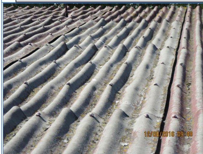
94. att. Skolas ēkas jumta viļņotās bitumena loksnes.
