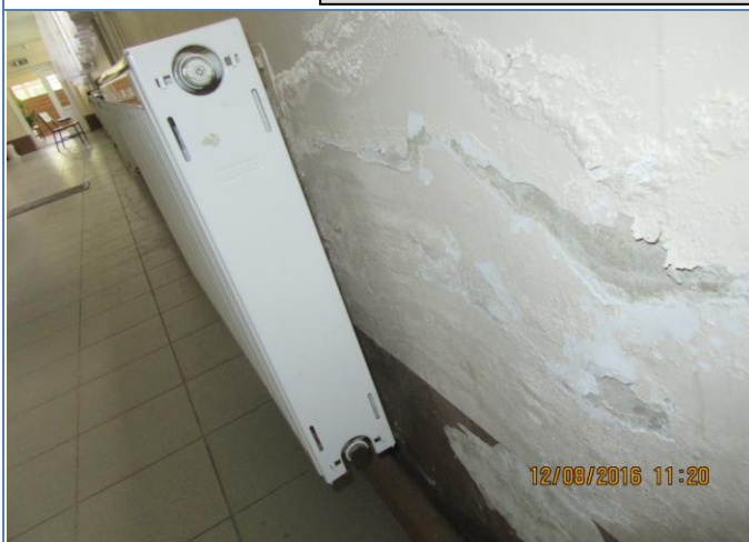
50. att. Sienas kapilārā mitruma bojājumi garderobes telpā.
