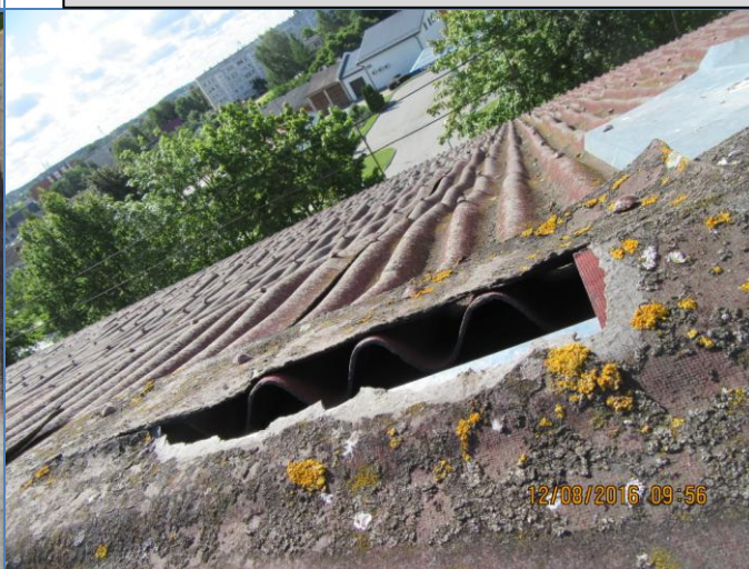
96. att. Skolas ēkas jumta viļņotās bitumena loksnes.
