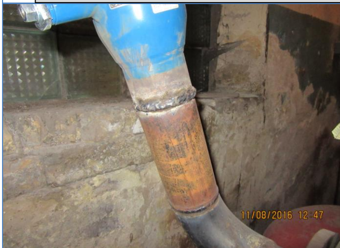
175. att. Nenosiltināts un nenokrāsots cauruļvadu posms .
