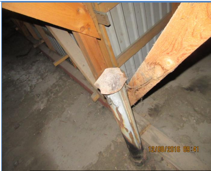
90. att. Neizvadīts gaisa vads virs jumta seguma.
