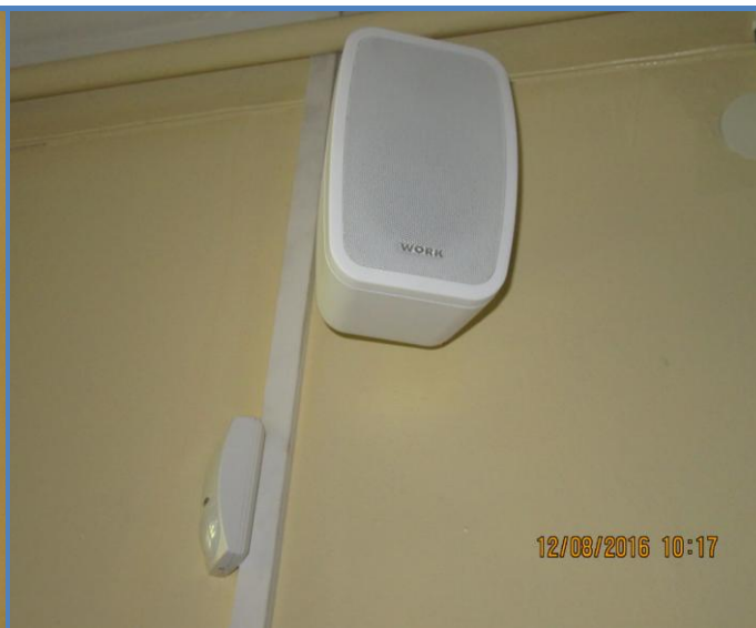
172. att. Balss apziņošanas sistēmas skaļrunis.
