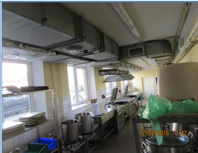
153. att. Ventilācijas sistēma virtuves telpās.
