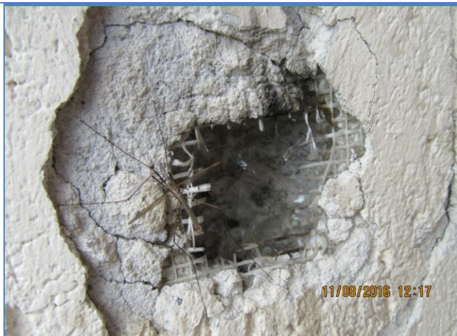
75. att. Bojājumi sporta zāles ēkas siltinājumā.
