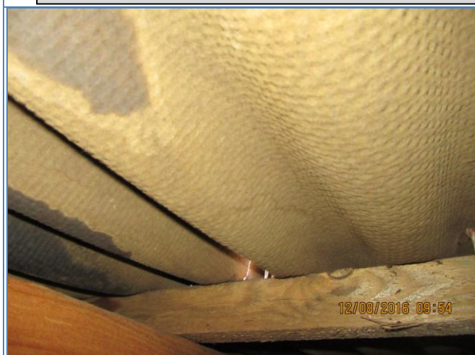
101. att. Jumta viļņoto bitumena lokšņu bojājumi.
