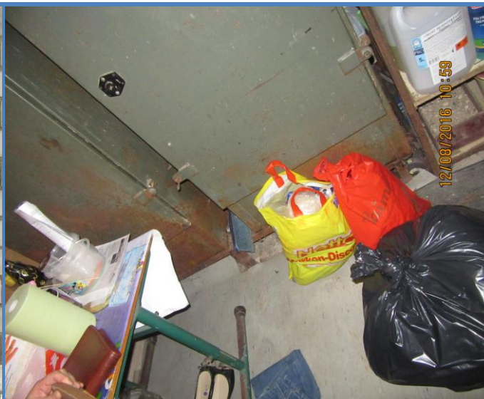
184. att. Skolas ēkas galvenā elektrosadales telpa tiek nepieļaujama izmantota mantu novietošanai.
