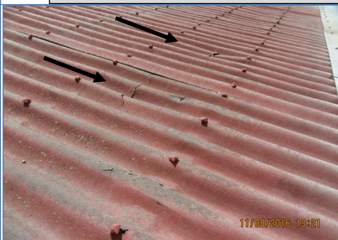
105. att. Bojāts jumta segums virs galvenā ieejas lieveņa, kas saistīts ar valsts karoga izkāršanu.
