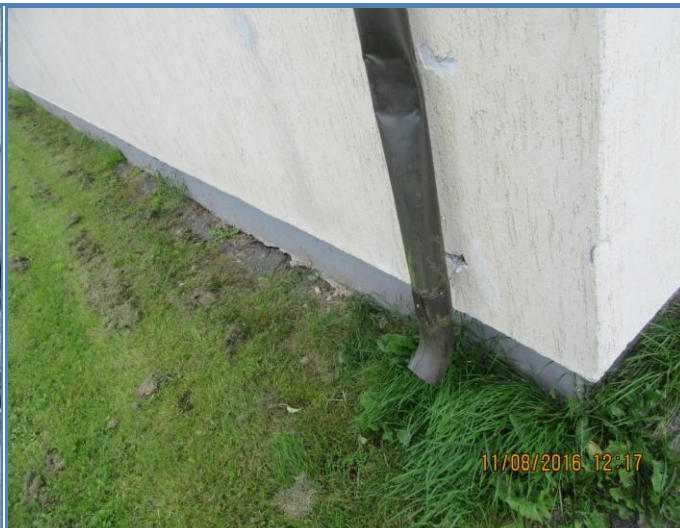
35. att. Neatbilstoša virspamata daļa sporta zāles ēkai.
