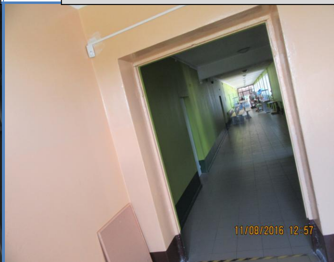
148. att. Ailes no kāpņu telpas bez durvīm neatbilst ugunsdrošības prasībām.
