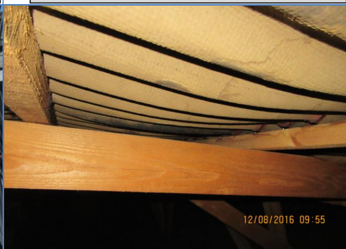
100. att. Jumta viļņoto bitumena lokšņu izliekumi.
