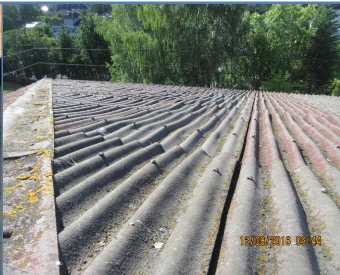
91. att. Skolas ēkas jumta viļņotās bitumena loksnes.
