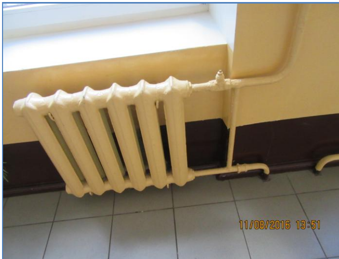
173. att. Čuguna radiators bez regulēšanas iespējām.
