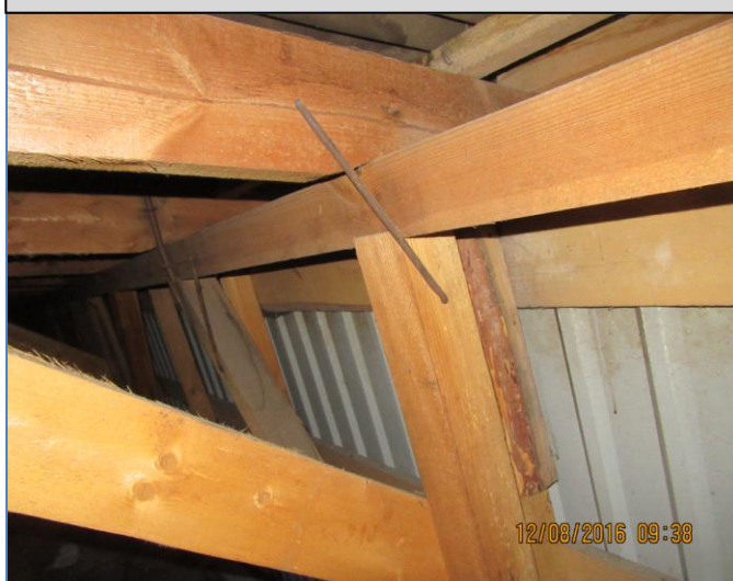
86. att. Jumta ārējās sienas koptura skavojums ar jumta spāri.
