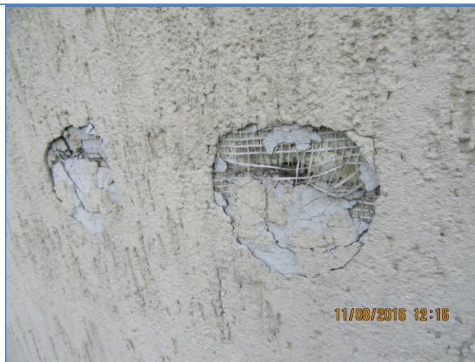
52. att. Sporta zāles ārsienas siltinājuma bojājumi.
