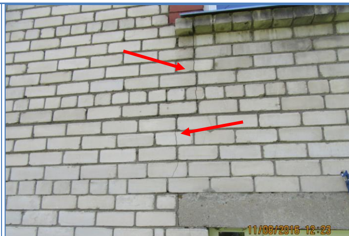
53. att. Virspusējs nenožīmīgs ārsienas plaisājums Raudas ielas pusē.
