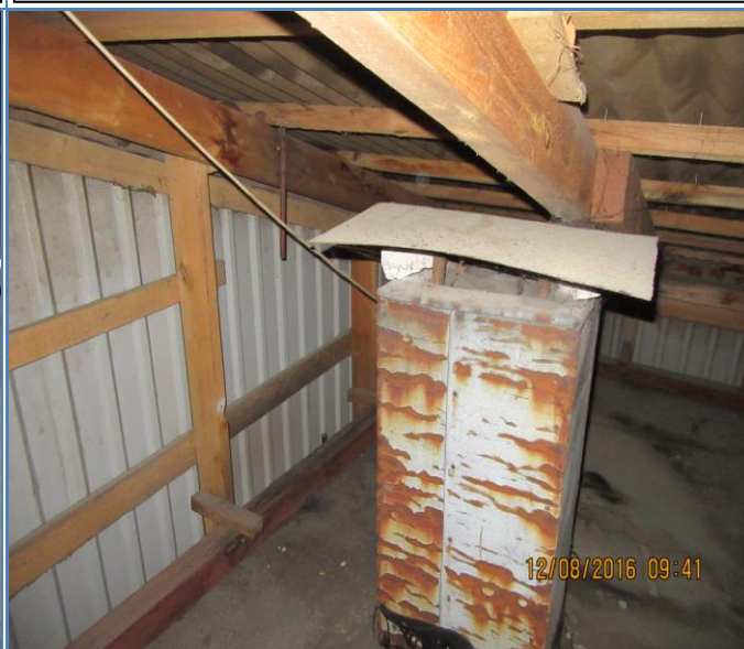
89. att. Neizvadīts gaisa vads virs jumta seguma.
